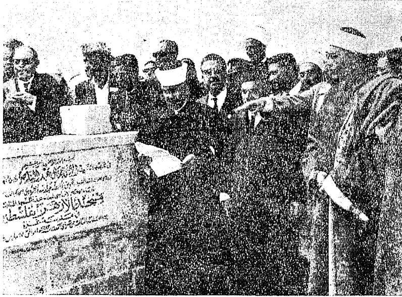
وضع الحجر الأساسى لبناء مسجد الأزهر بـفلسطين
